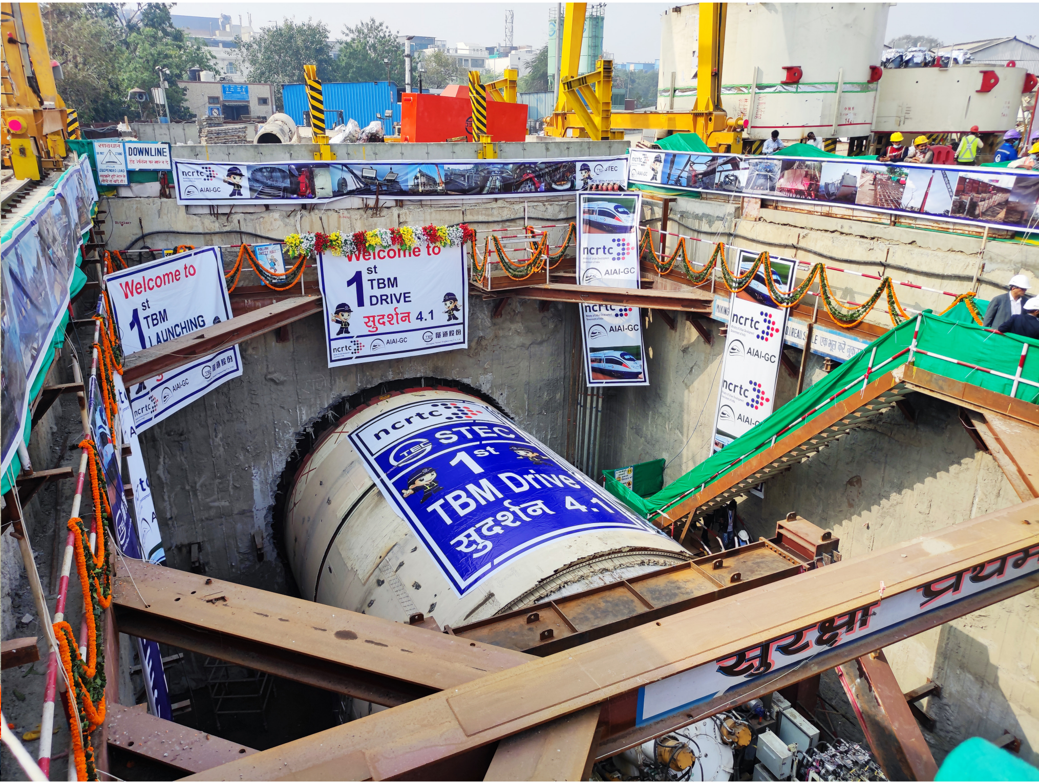
• 印度德里NCRTC城际快铁项目盾构始发
