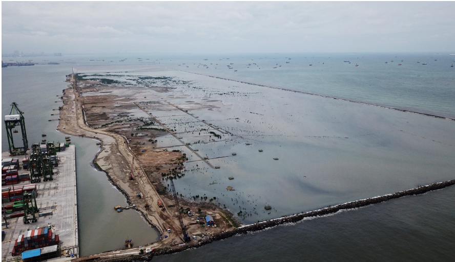
• Kalibaru港口项目，是印尼第一个采用吹填淤泥围海造地的大型基建工程
