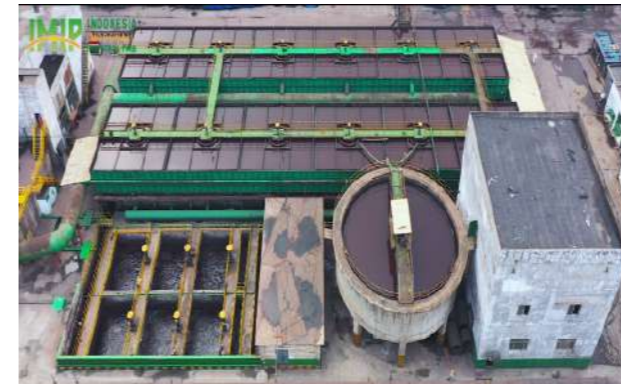
生产废水处理站
