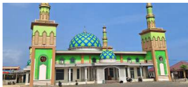
努鲁·塔克瓦清真寺宣礼塔建设
