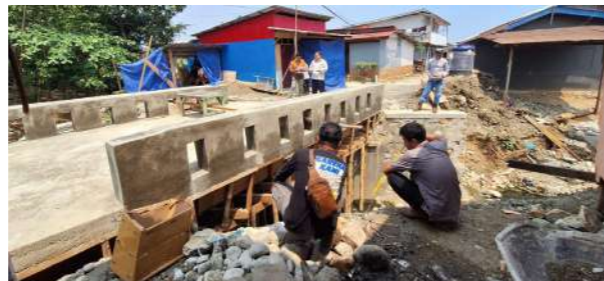
巴霍马斯穆尔村五区第二地点桥梁建设
