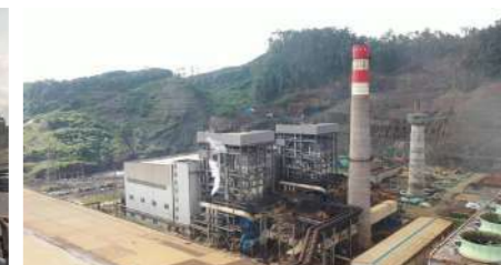
PT.DSI 2*100MW 发电厂
