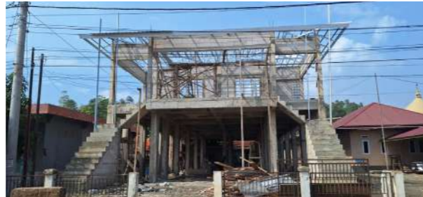
拉兰普村会堂建设
