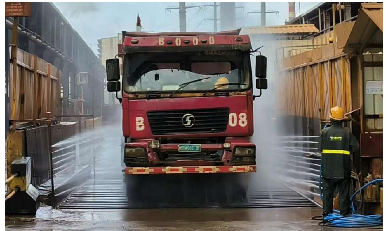
雨水回收用于洗车台洗车
