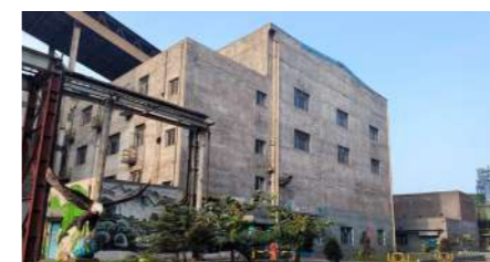
PT.DSI 1*15MW 余热发电厂
