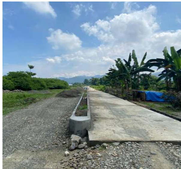
丹帕拉村道路路面工程
