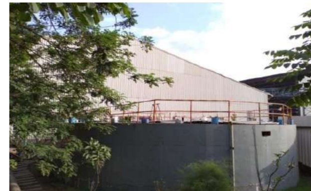
生活污水收集池
