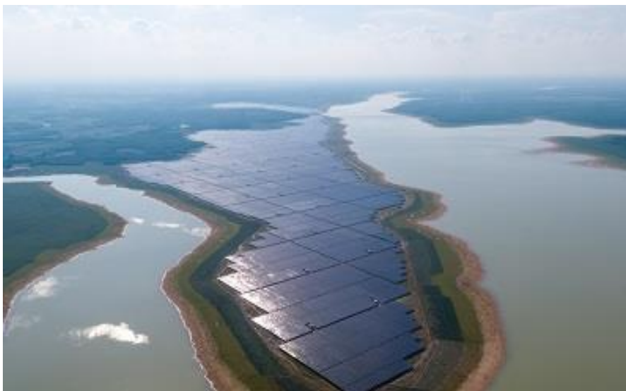
越南油汀太阳能电站
