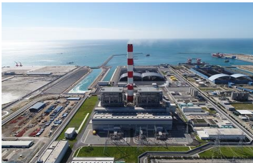
永新一期燃煤电厂
