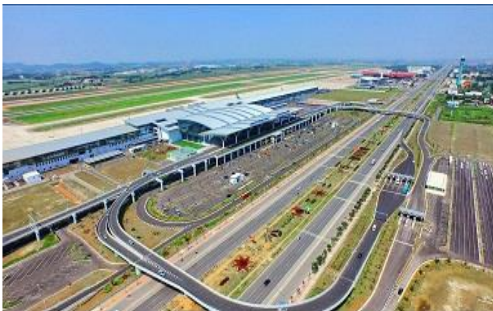
河内内排机场
