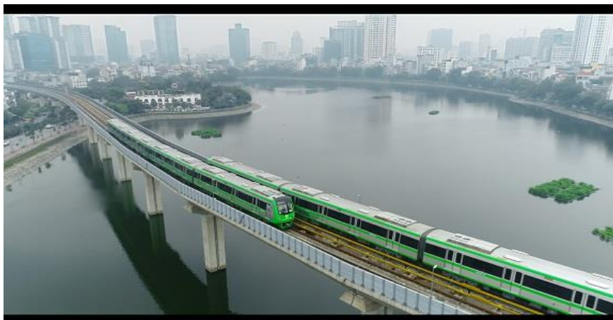
河内轻轨二号线（吉灵—河东段）
