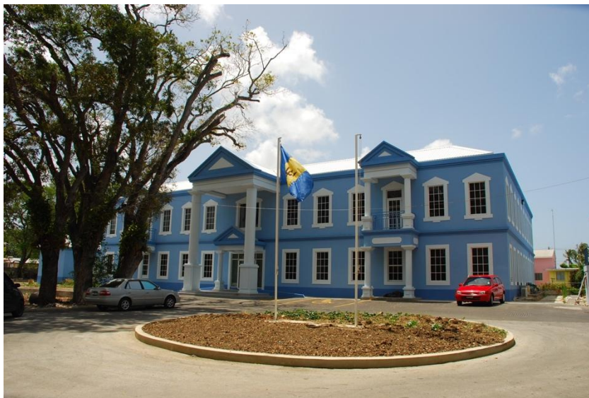
中建承包项目——工会新办公楼
