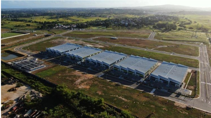
凤凰工业园-北京建工承建
