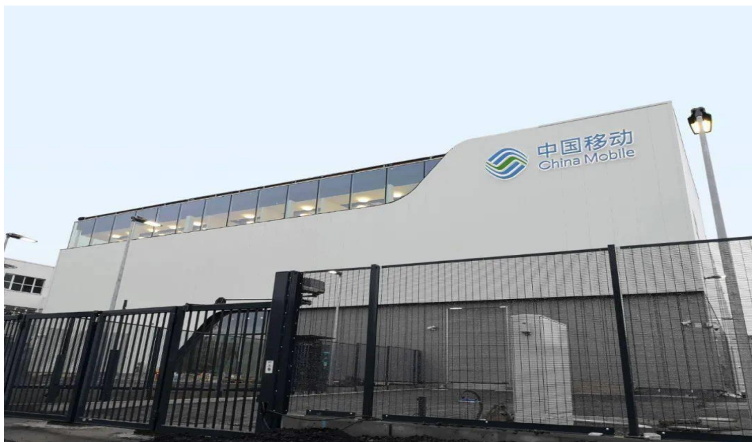
中国移动国际有限公司德国数据中心
