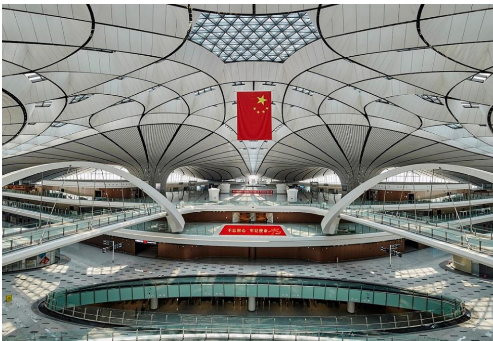
瑞客矿物漆被用于北京大兴新机场核心区域
