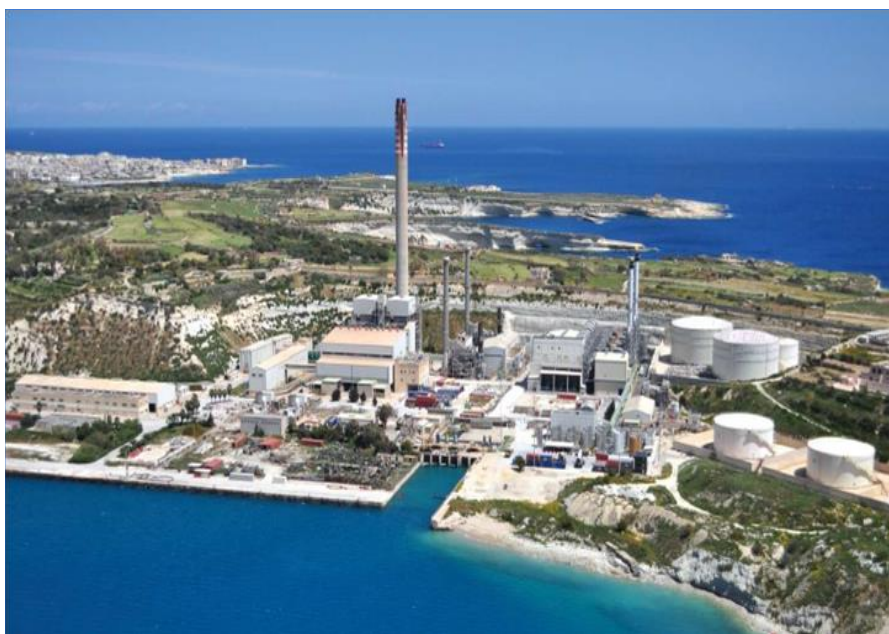
上海电力马耳他D3电厂
