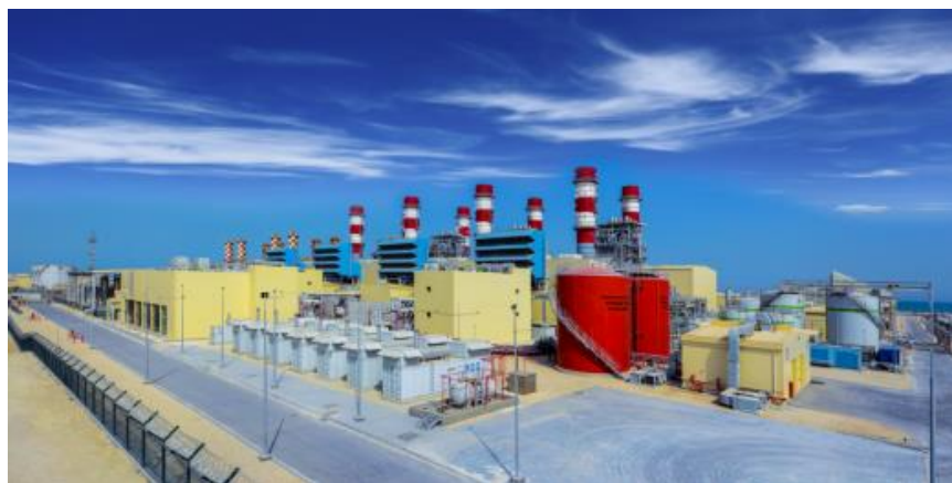
东电建三公司承建的巴林阿杜电站二期1540兆瓦燃机电站项目
