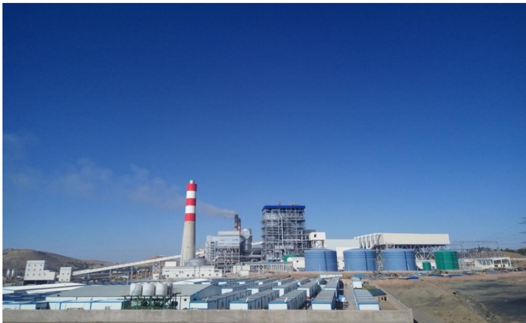
山东三建承建的杰拉达火电站项目
