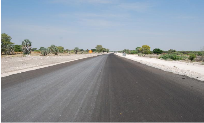
北部公路项目现场（河南国际集团承建）
