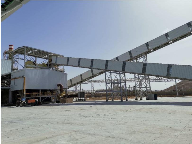
东华科技承建突尼斯化工集团项目
