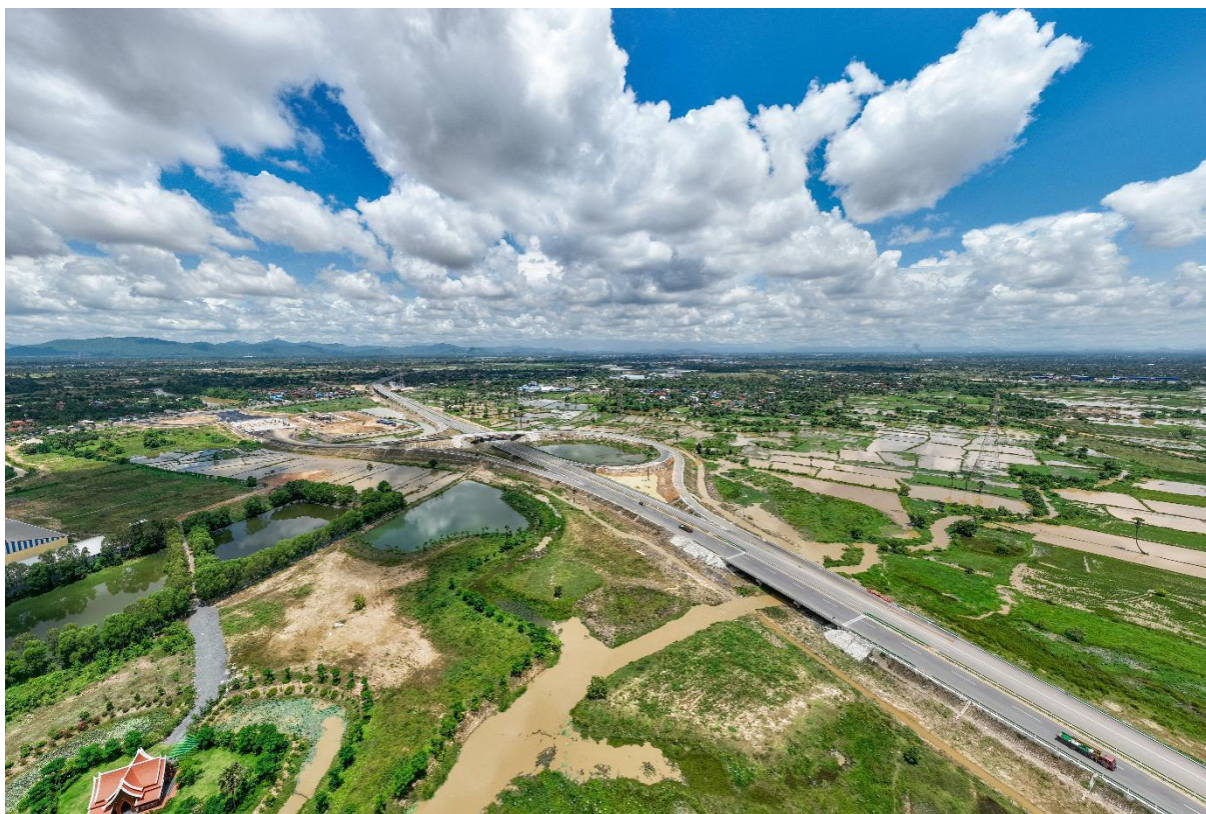
金港高速公路
